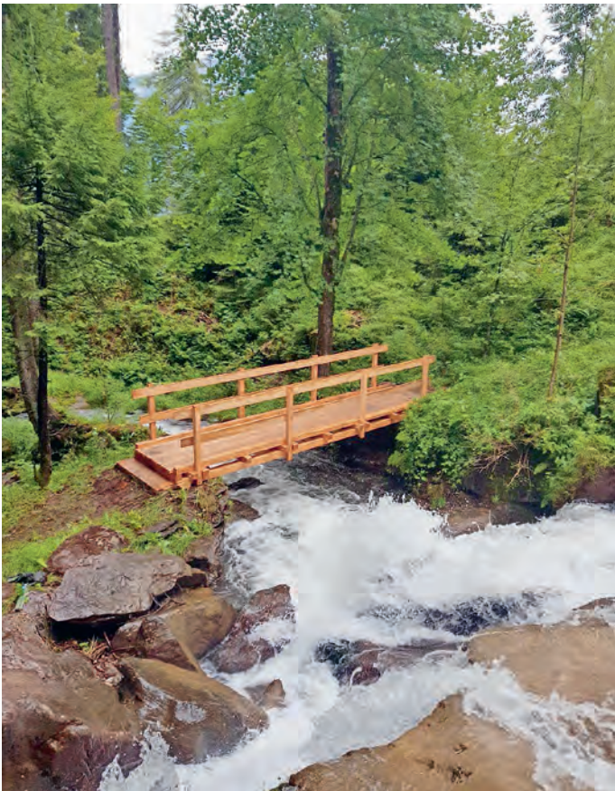
Brücke Sprung, Schigg Mädris
