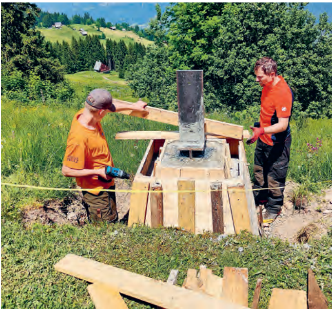
Schalung Fundament Alpkreuz Hochschwendi
