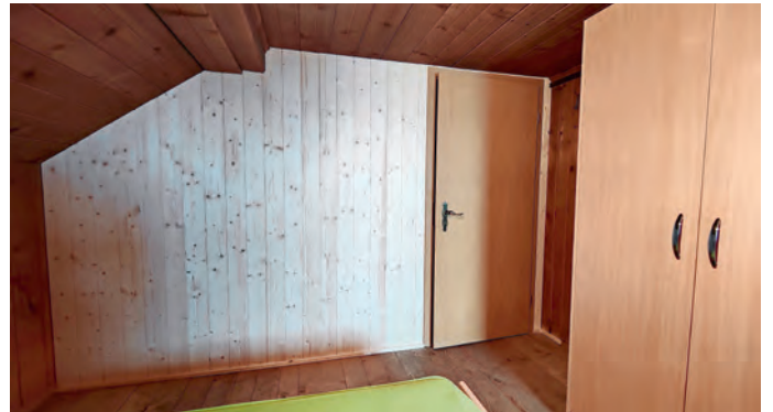
Trennwand Treppenaufgang Schwarzenberg
