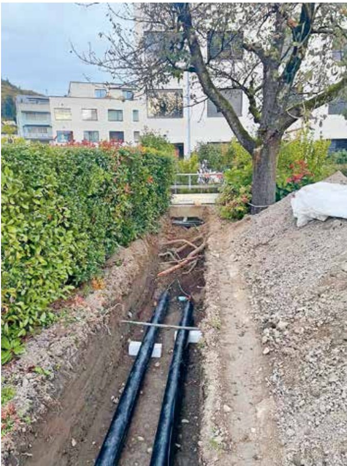
Erweiterung Fernwärmeleitung im Bereich «alte Drucki»
