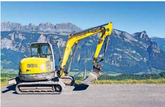
Baggerschlitz erstellen, Hochschwendi
