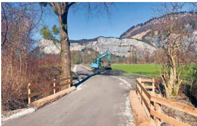
Neuer Lärchenzaun zur Sicherung des Giessenüberganges
