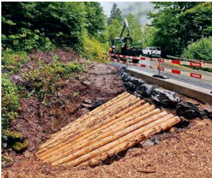
Einlaufrost Bach Weisstannerstrasse
